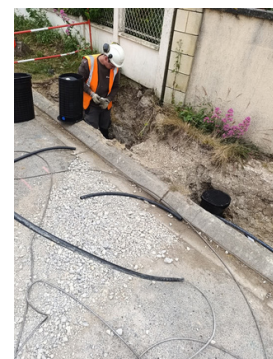
Travaux enfouissement des réseaux à Jumeaux
