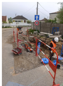
Raccordement Réseau d'eau - Rue des Bordes
